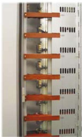
Vista posterior del CCM, barra vertical en el ducto metálico y garras de salida.
